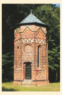
werk seiner Art. Rundstäbe und das Mauerwerk, im Wechsel aus glasierten und unglasierten Ziegeln errichtet, weisen auf seine spätromanisch-frühgotische Prägung hin.
