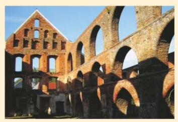
Segmentbogenfenster mit Rahmenblenden, Kleeblattfriese am Fuße der Giebel gliedern und schmücken die Flächen. Westlich schließt sich das Mühlenhaus an. Sein Giebel wird durch gestaffelte Spitzbogenblenden über einem Kleeblattbogenfries geprägt. An der Nord- und Südwand des Mühlenhauses befinden sich die Durchlässe für den heute wieder ein Mühlrad antreibenden Mühlbach. In einem künstlich erhöhten Bett wird er von Süden herangeführt und noch heute durch das Gebäude geleitet.
